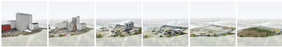
Figure 4.3.6 30.07.2010 / 17.09.2010 / 03.08.2011 / 25.09.2012 / 21.07.2014 / 19.11.2015 Sky and park surface covered with transparent surface
